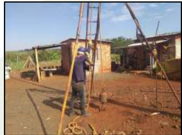
Execução de sondagem SPT
